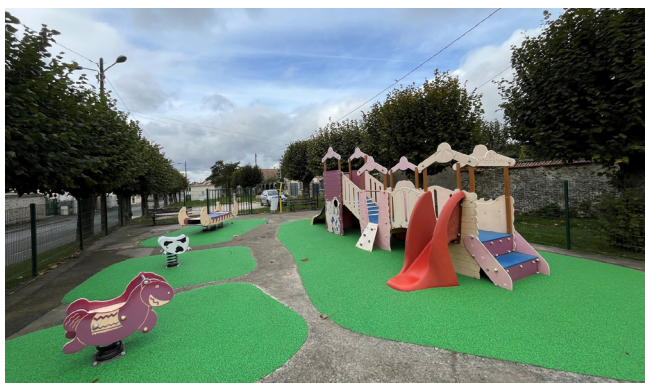
Pose de nouveaux sols amortissants à l'aire de jeux, boulevard Louis Durand Octobre 2025
