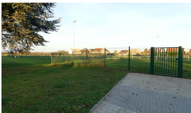
Mise en place d'un nouveau grillage au stade Décembre 2025
