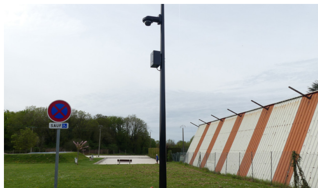
Installation d'une caméra de surveillance sur le parking d'accès aux terrains de tennis Octobre 2025
