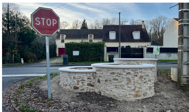
Installation de massifs en pierre aux Bordes Décembre 2025
