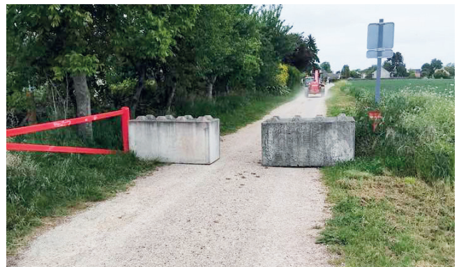
Pose de vigibloc sur la voie douce Mai 2025
