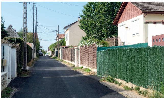
Réfection de la chaussée rue de la Garenne Mai 2025
