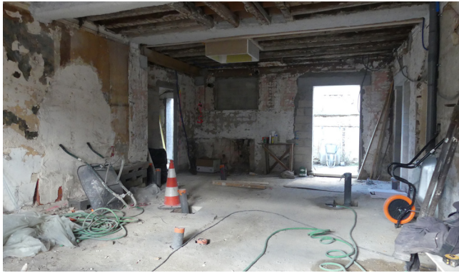
Les travaux continuent au Café de paris Premier semestre 2025
