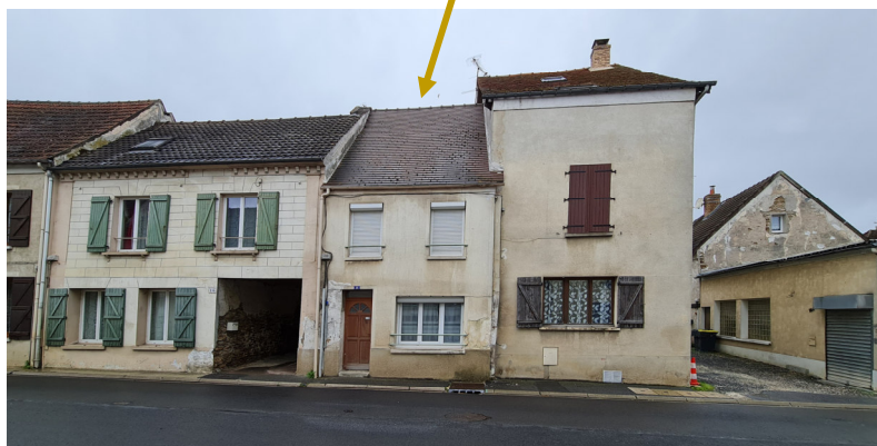
Au n°18 de la rue, au même endroit Photo : I. Aubertin - 2023
