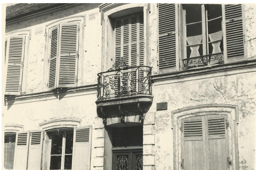
Balcon du 1 er étage du 3 rue des Moutiers - Photo milieu XX ème siècle
