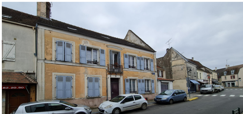
Au n°3 de la rue - Photo : I. Aubertin - 2023
