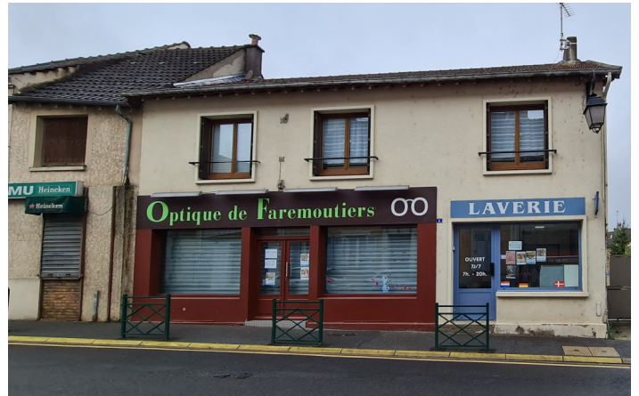
N°4 et 4bis de la rue Photo : I. Aubertin - 2023
