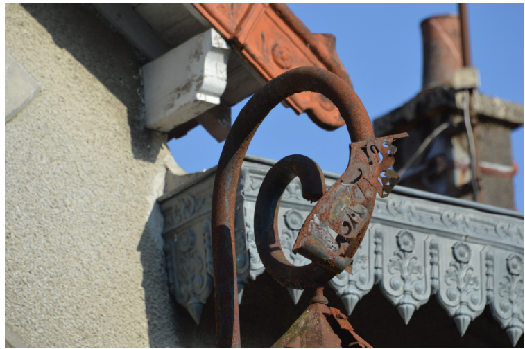
Détail d'architecture du château "Madeleine" Photo : B. Dumont - 2023
