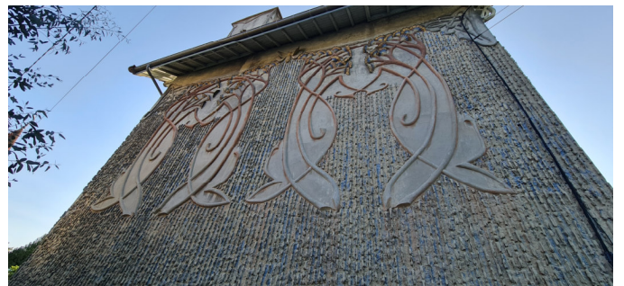
Détail du mur pignon de la maison "Rustica" Photo : I. Aubertin - 2023
