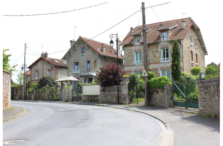
Le même endroit en 2023 Rue Foch - virage avec l'avenue du Commandant Arnaud - Maison Rustica au centre Photo : N. Lucas - Association "Regard en Coin"
