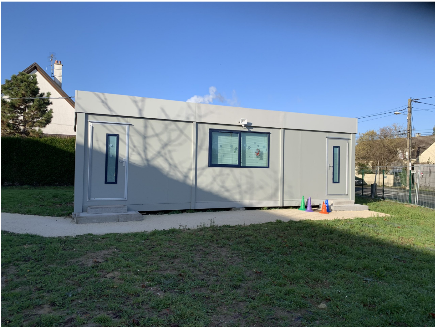
Groupe scolaire Simone Veil situé au 29 Boulevard Louis Durand
